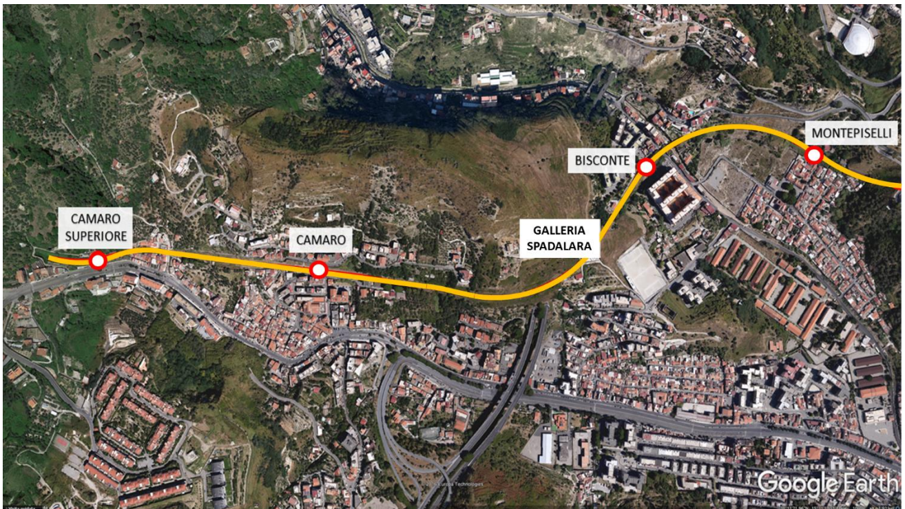
Fig. 29 - Vista aerea del tratto di linea compreso tra la galleria Montepiselli e l'inizio della vecchia galleria del Peloritani
