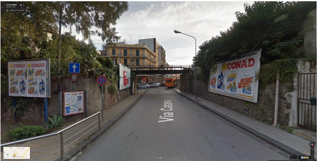
Fig. 18 - Ponte ferroviario in ferro fuori esercizio di via Catania (punto C di fig. 17)
