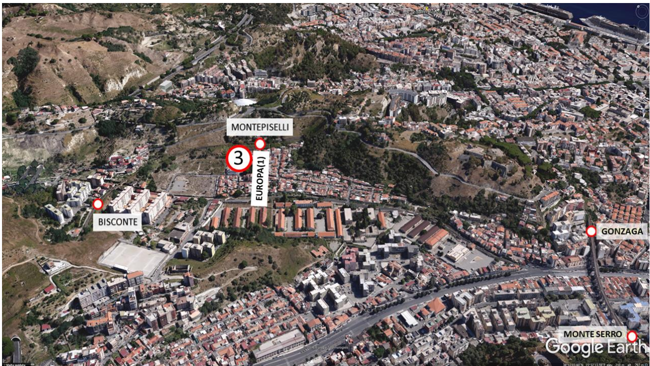
Fig. 28 Vista aerea dell'area compresa tra Bisconte (sulla sinistra) e il ponte di Camaro (sulla destra)
