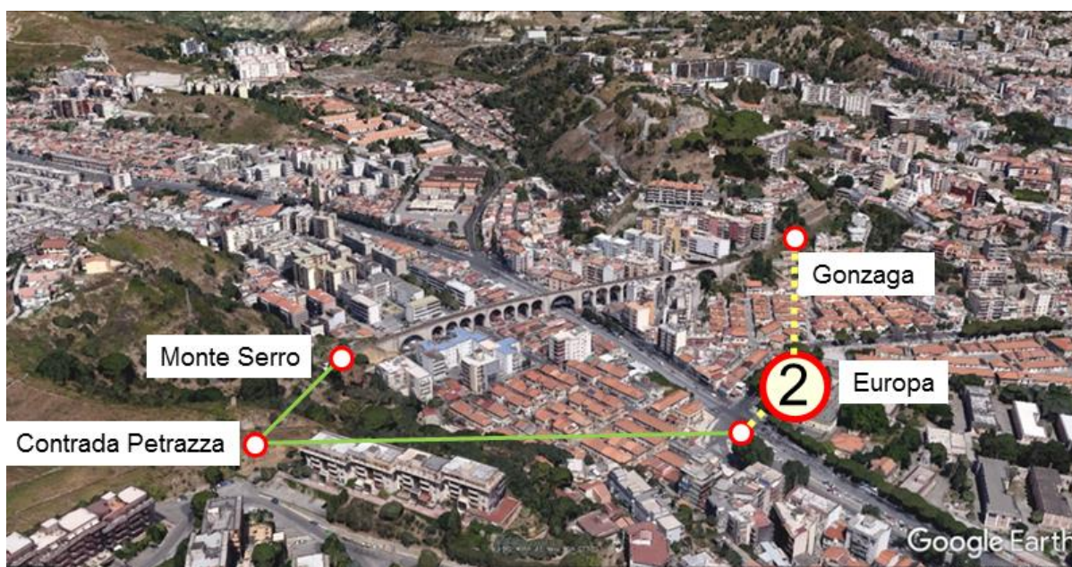
Fig. 25 - Vista del Ponte di Camaro
