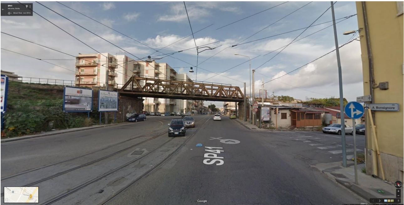
Fig. 19 – Ponte ferroviario in ferro fuori esercizio di via Bonsignore (punto D di fig.17)
