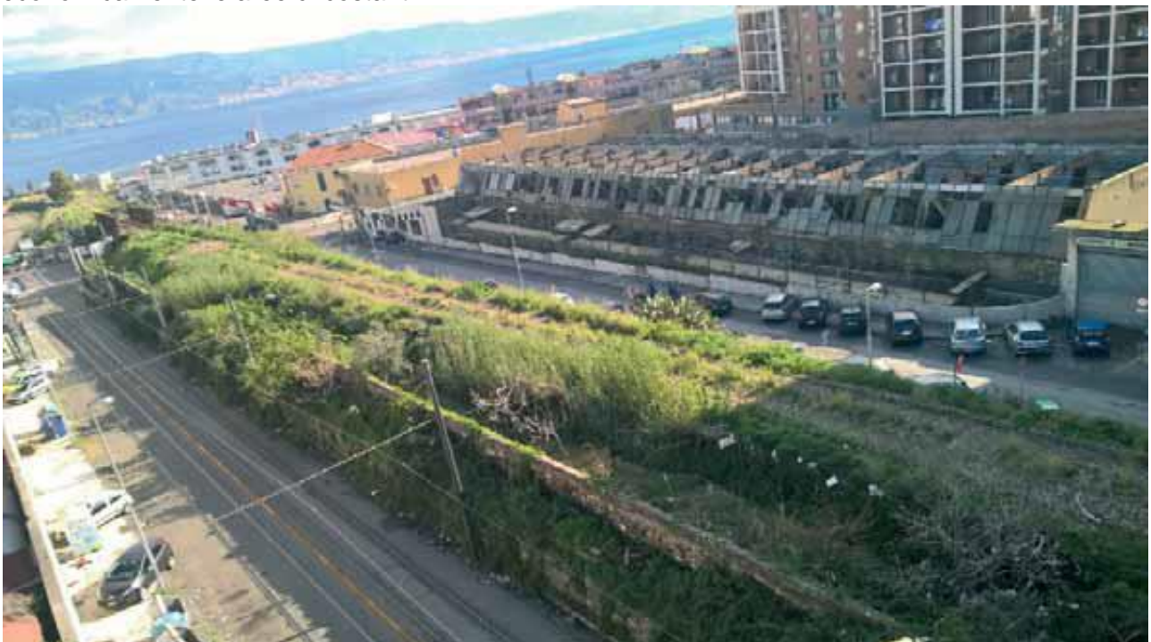
Fig. 20 - Rilevato ferroviario compreso tra via Gazzi e via Bonsignore (punto E di fig.17)
